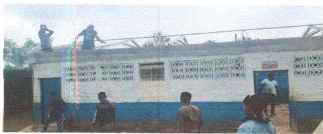
Foto 5: Colocación de estructura metálica del escuela módulo 3
