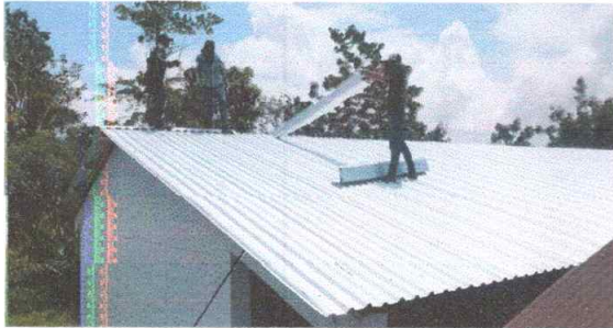
Foto 1: Colocación de la estructura metálica de la escuela de módulo 1
